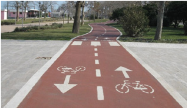
Pista ciclabile in asfalto colato
