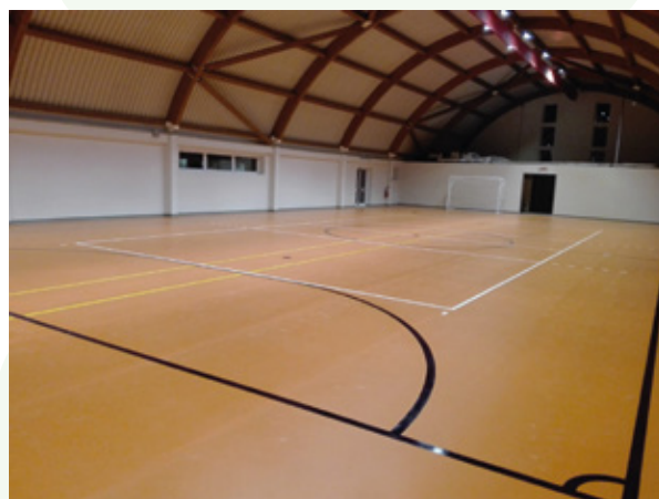
Pavimentazione in vinilico flessibile
