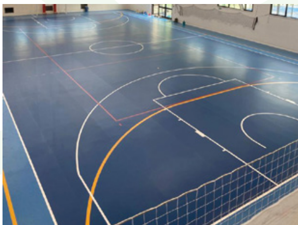
Pavimentazione indoor in resina
