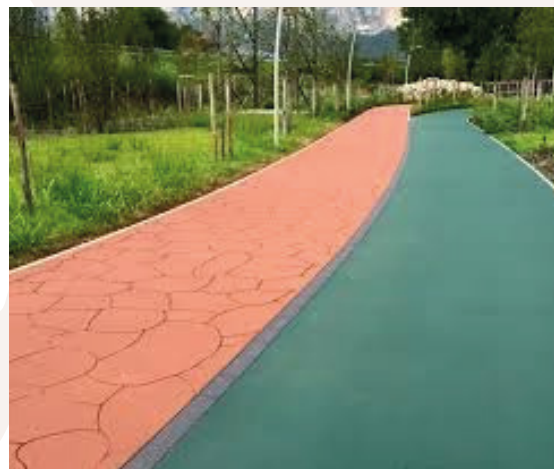
Pista ciclabile in asfalto colato di diversi colori
